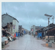
輪島市内の被災状況
