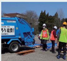
がれき回収作業
