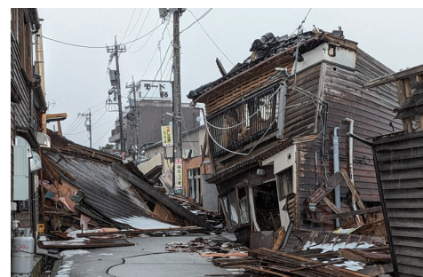
倒壊寸前の木造家屋 (輪島市内)
